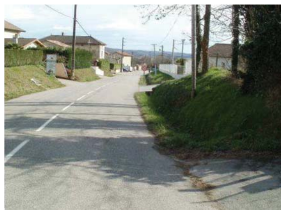
Pluvial de la route de Vernioz
