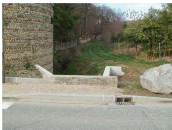
Exemple d'aménagement pluvial sur la RD
