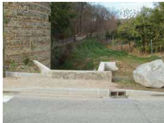
Exemple d'aménagement pluvial sur la RD
