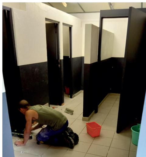
Les sanitaires de la grande salle ont été rénovés par les agents du chantier d'insertion du CIAS Carmausin-Ségala en collaboration avec nos agents municipaux. Restent à ce jour, la réfection de la toiture des sanitaires et la pose d'un faux plafond doté de luminaires LED.
