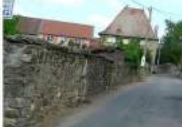
Les murs traditionnels de la Murette sont en galets et pierre, parfois surmontés d'une couvertine en pierre, dont les joints et mortier sont à base de chaux.
