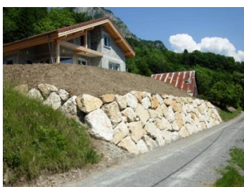
Exemple d' enrochements interdits
