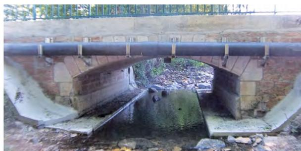
Échancrure réalisée dans le tablier béton sous le pont, rendant le seuil franchissable pour la faune et les sédiments (travaux réalisés par le conseil départemental de Saône-et-Loire)
