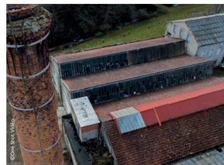
Toiture en shed de l'usine SAB sur la commune de Montferrier
