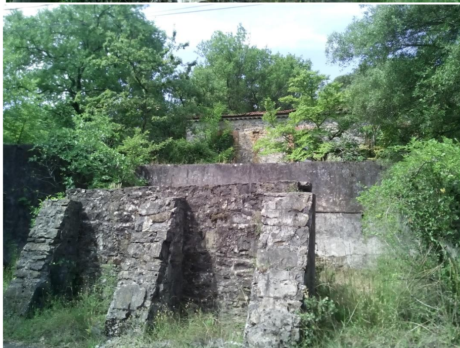
Figure 7 Ancien bâtiment et écuries (en bas)
