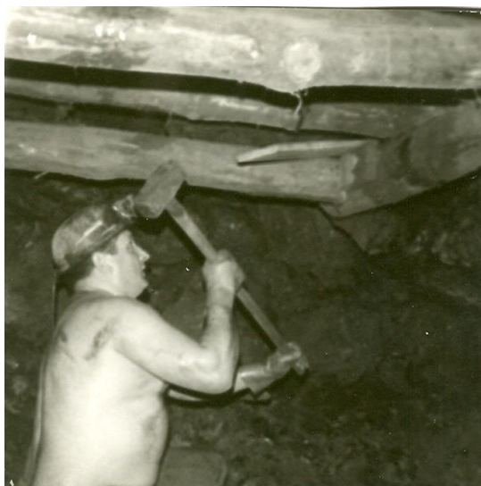
Figure 23 : Un mineur en train de boiser une galerie
