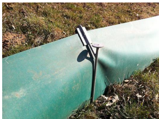
☞ Photographies 19 et 20 : Exemples avec construction en porte-à-faux avec poteaux de retenue pour amphibiens et reptiles, coudés à 45° au-dessus pour protection antichute (Source : maibach.com)
