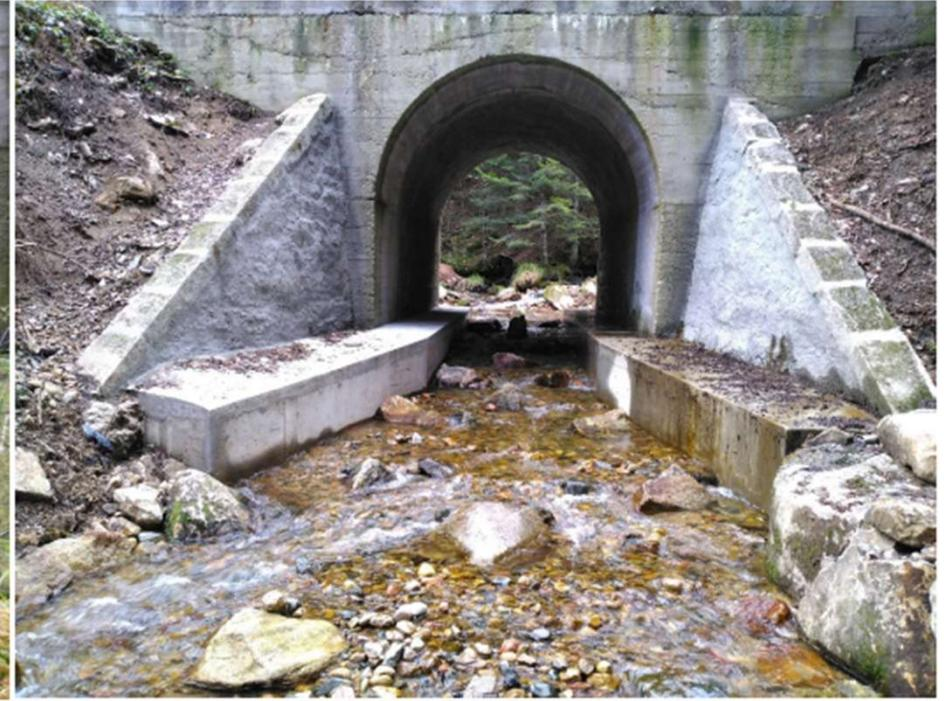
Illustration 18 Ruisseau de Faye (RD dept 42) – CESAME B-Ingénierie 2021 Etat initial (gauche) et 1 an après travaux (droite). Reprise en sous œuvre par longrine béton et micropieux
