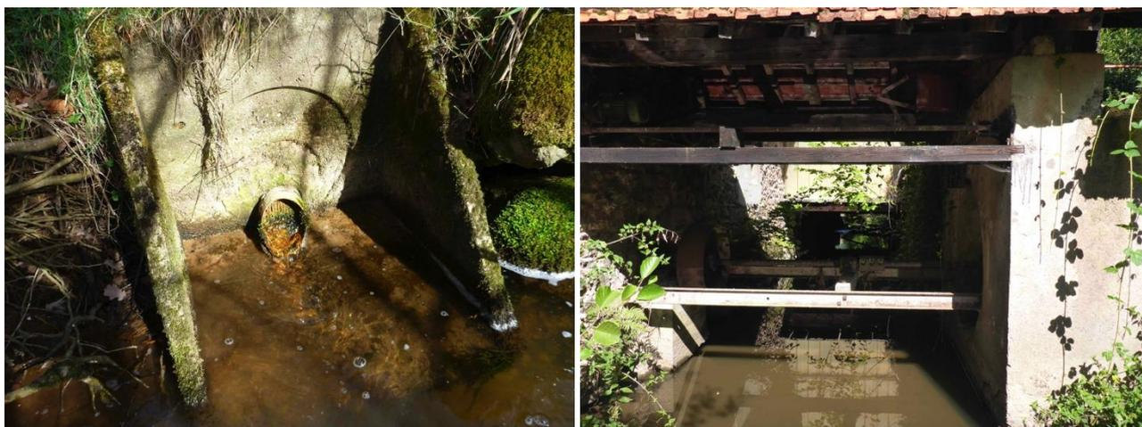
Illustration 4 : Rejet de drain à l'aval immédiat de l'ouvrage SB107 (à gauche) ancienne installation hydraulique de l'ancienne scierie associée au seuil (à droite).
