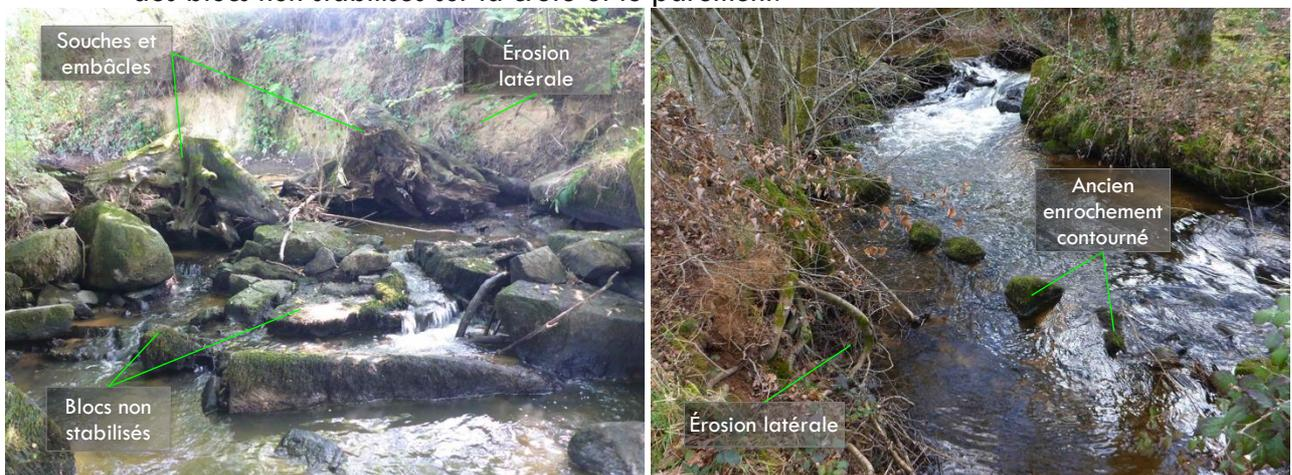
Illustration 10 : Vue de détail du seuil Aa63 (à gauche) et de l'érosion latérale en aval (à droite).
