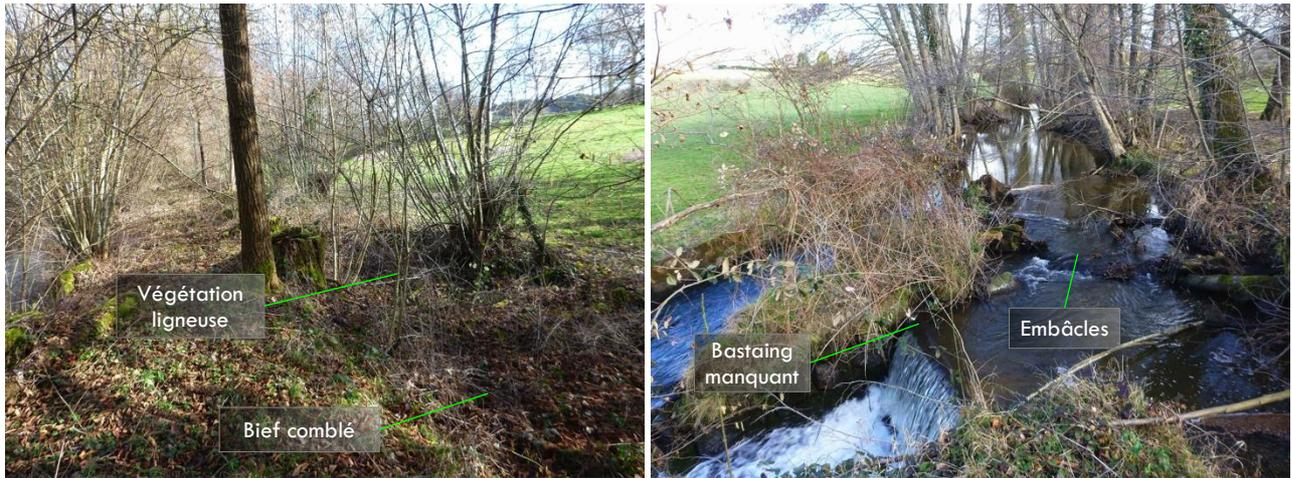
Illustration 9 : Vue de détail du bief (à gauche) et du dispositif de décharge / dessablage au départ du bief (à droite).
