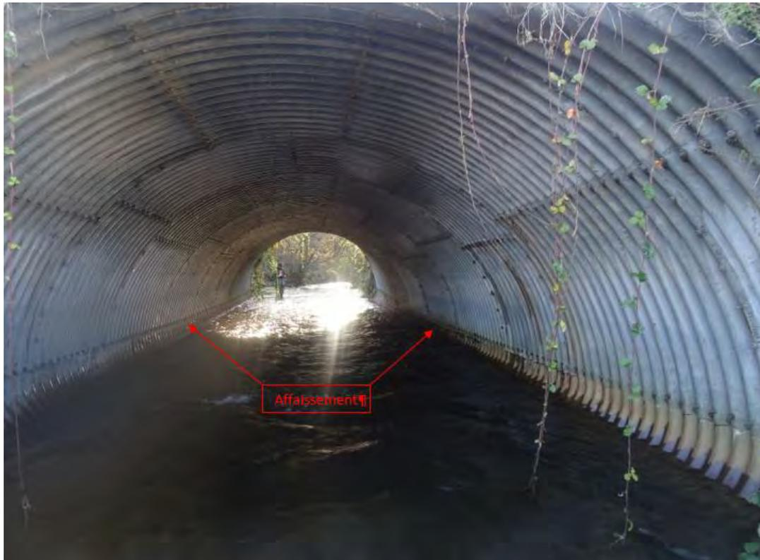
**Figure 5 : Affaissement repéré sur l'ouvrage BOTO\_19**
