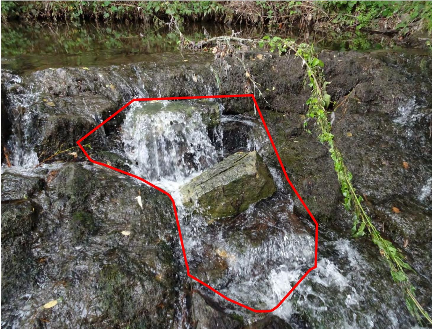
Commentaire : Descellement important de blocs constituant le seuil. Ces descelllements ont pour conséquence un abaissement du niveau du seuil et une accélération du débit à cet endroit.
