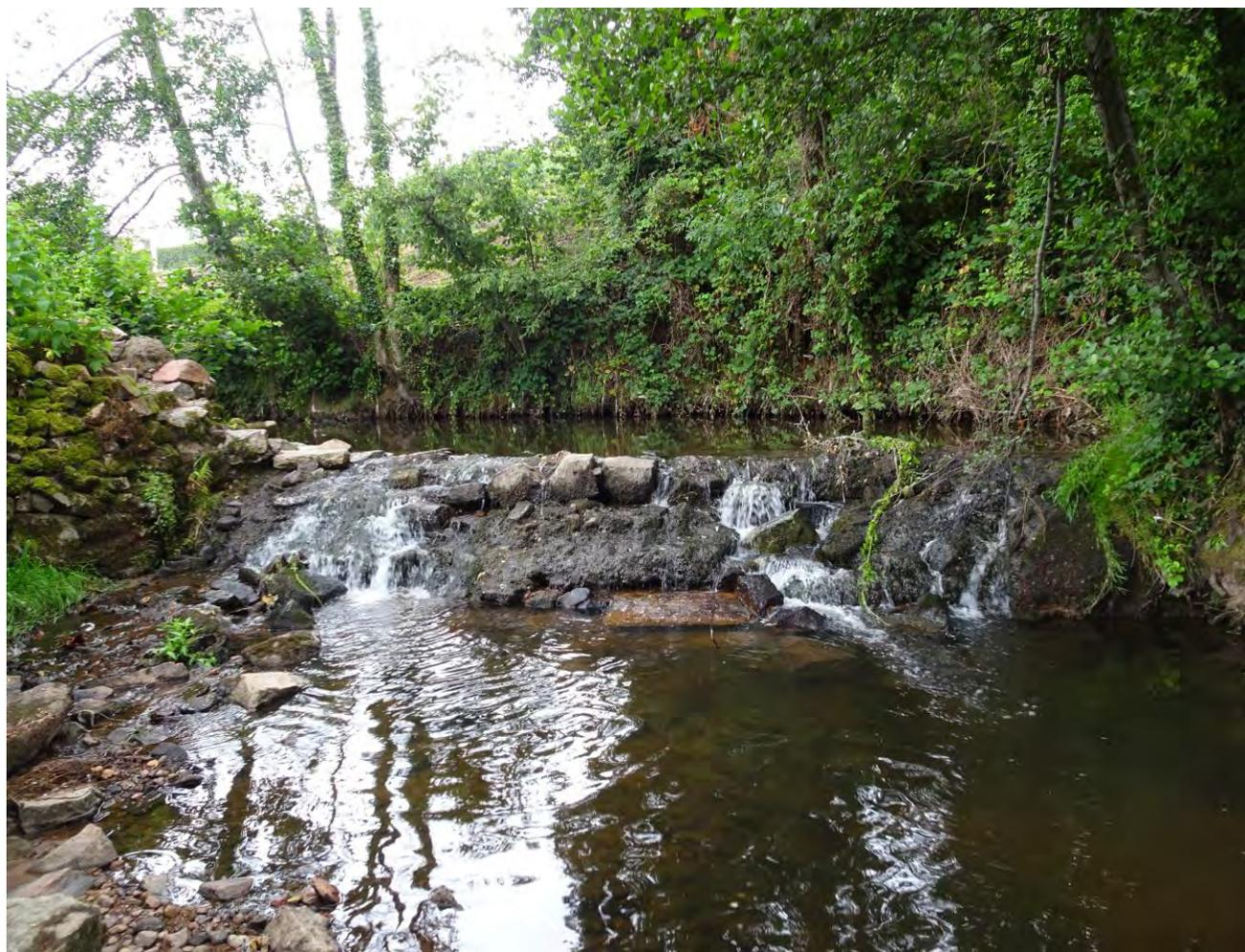
Commentaire : Une érosion globale a été constatée l'ouvrage. Des descellements ont également été observés. L'érosion est plus marquée à ces endroits. Des zones de sédimentations ont été relevées au milieu du cours d'eau et en pied de seuil.
