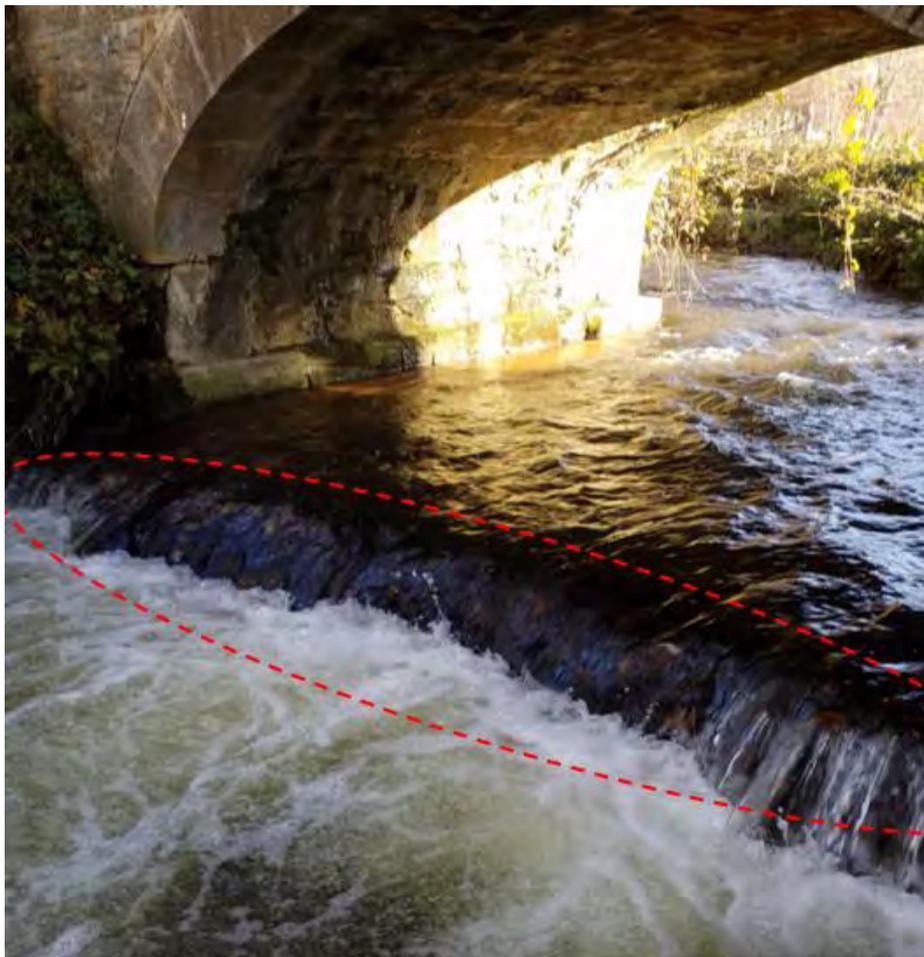
**Figure 6 : Affouillement profond sur la totalité du linéaire du seuil observé sur l'ouvrage SB124**
