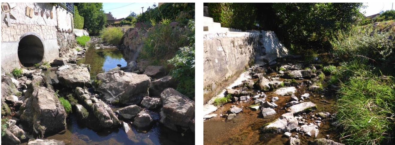
Illustration 13 : Micro-seuils en blocs libres 75 mètres (à gauche) et 105 mètres (à droite) à l'amont de l'ouvrage SB70.
