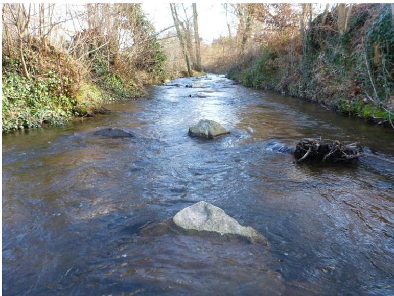
Illustration 35 : Mise en place de blocs pour diversifier les écoulements au sein du lit du Botoret 250 mètres en amont de l'ouvrage.
