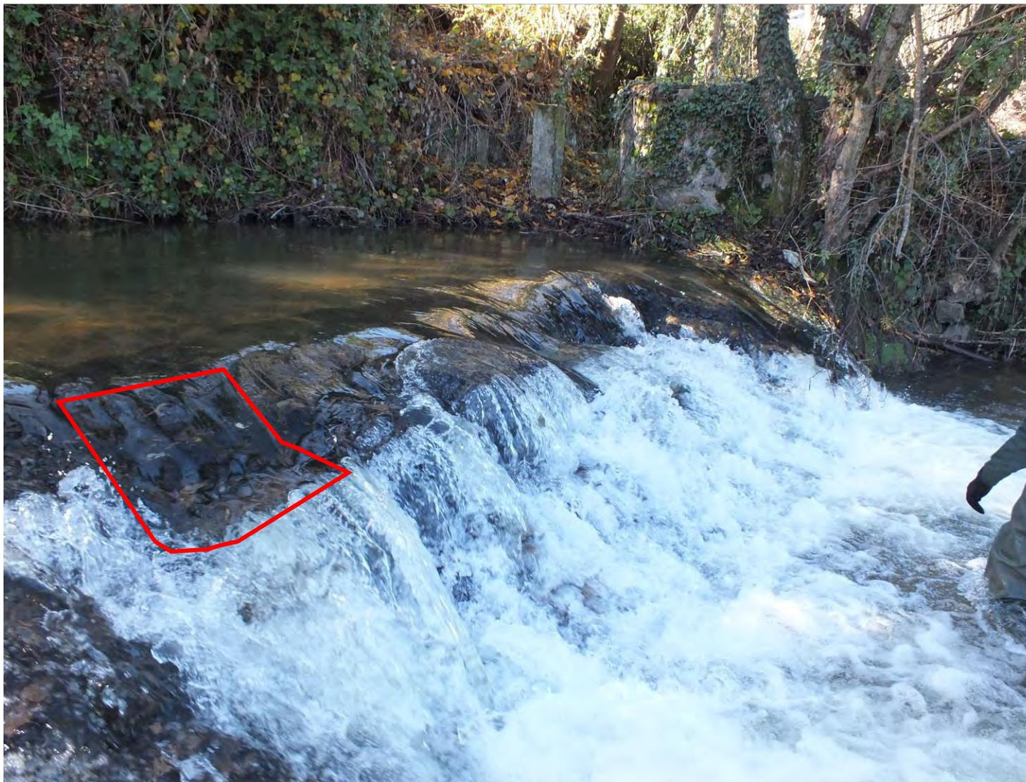
Commentaire : Descellement important de blocs constituant le seuil. Les blocs semblent être présents en pied. Ces descellements ont pour conséquence un abaissement du niveau du seuil et une accélération du débit à cet endroit.
