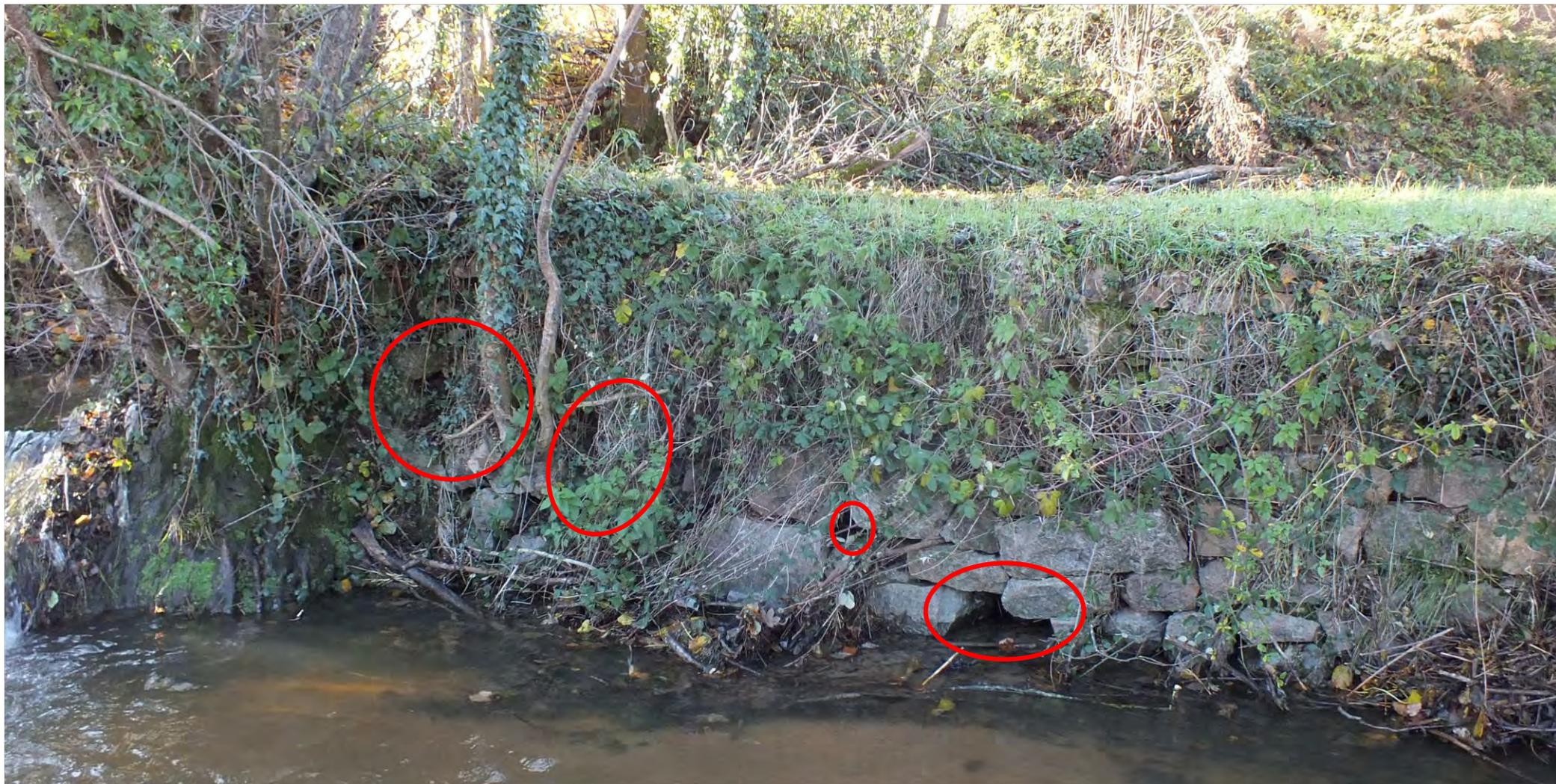
Commentaire : Descellements multiples sur mur de soutènement en pierres sèches. Mauvais état général avec fruit négatif.
