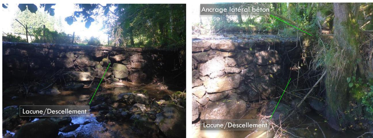
Illustration 7 : Vue de détail du départ du bief (à gauche) et du bief comblé (à droite).
