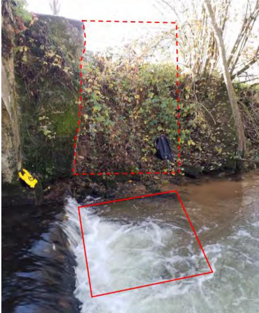
**Figure 7 : Instabilité du mur de soutènement avoisinant l'ouvrage SB124**
