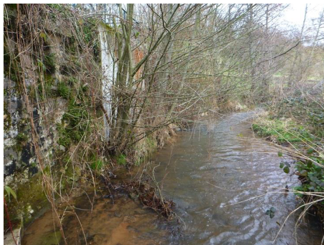
Illustration 14 : Ecoulements en amont immédiat du pont Source : CESAME 2019
