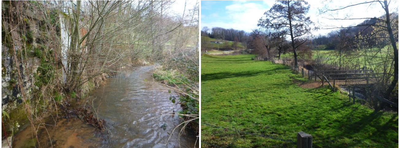
Illustration 5 : Mur de soutènement amont (gauche) et mise en défens du Chandonnet sur la parcelle amont (droite) Source : CESAME 2019
