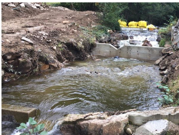
Illustration 27 : Pré-barrage béton (en cours de pose) sur le Riotet et pré-barrage bois sur le Jarnossin Source : photos CESAME/B-Ingénierie
