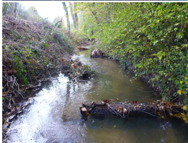
Illustration 31 : Exemple de diversification par blocs (haut) et épis bois (avant gauche /après droite) Source : Photo CESAME, conception/suivi SYMISOA (blocs) et CESAME (bois)
