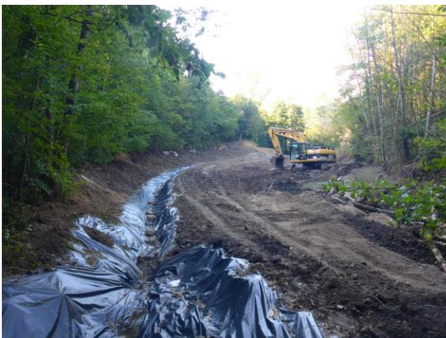
Illustration 21 : Exemple de chenal de dérivation bâché sur un chantier d'effacement de plan d'eau.
