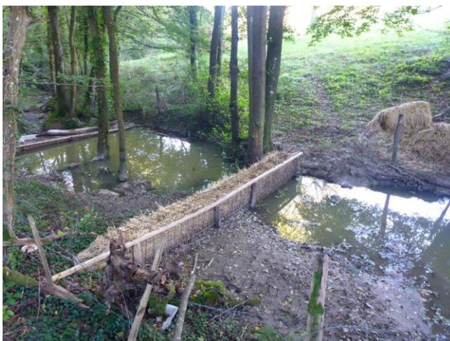
Illustration 20 : Exemple d'une succession de deux filtres à MES en aval d'un chantier d'effacement de plan d'eau.
