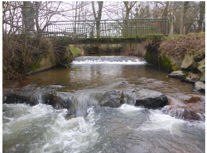
Illustration 20 : Prédimensionnement du pré-barrage aval à l'aide de la formule de Kindsvater et Carter Source : CESAME 2021
