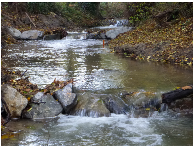
Illustration 23 : Pré-barrage blocs sur le Jacquelin (gauche) et l'Ander (droite) Source : Conception (CESAME), maîtrise d'œuvre (CESAME/Saint-Flour-Co)
