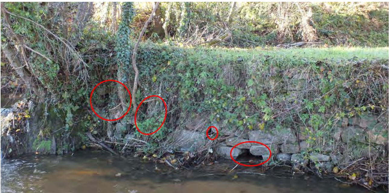
Figure 4 : Descellements localisés sur un mur de soutènement avoisinant l'ouvrage SB70 et remettant en cause sa stabilité
