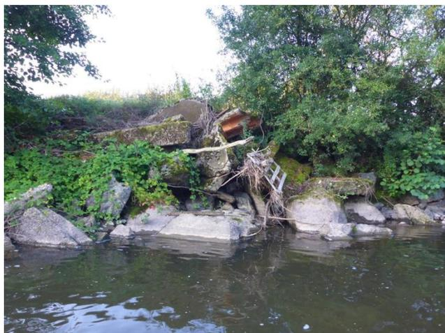
Illustration 16 : Érosion du front de talus amont (à gauche) et berge artificialisées en aval (à droite) du seuil.
