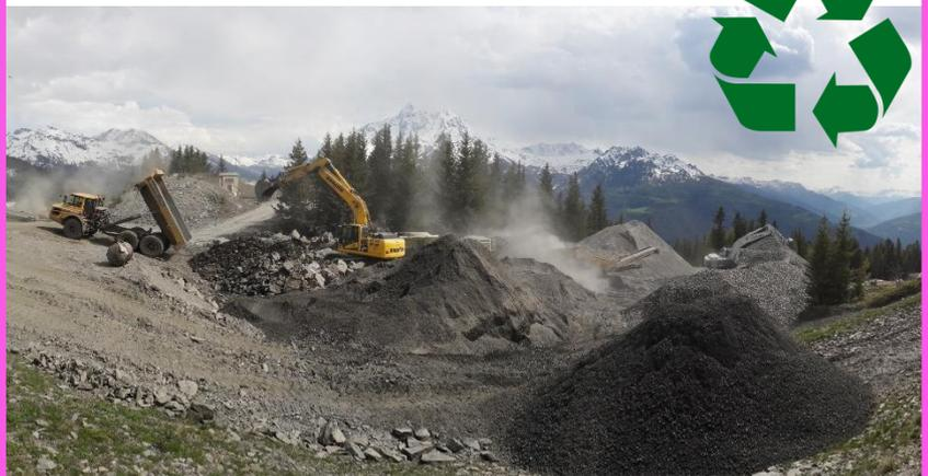
Pour la phase de terrassement, le Club Med a fait installer sur site un concasseur qui permet de **recycler 12 500 m<sup>3</sup> de pierres** et rochers directement extraits des fouilles par les pelles mécaniques :
