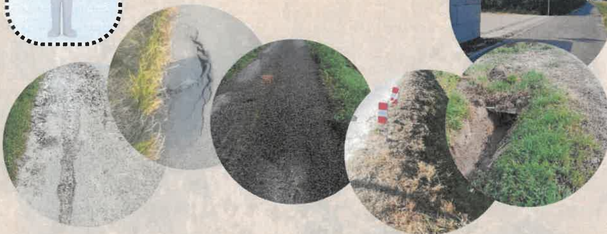
des dizaines de travaux réalisés
