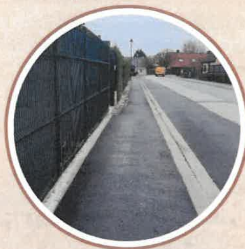
Création d'un trottoir rue de la Briqueterie
