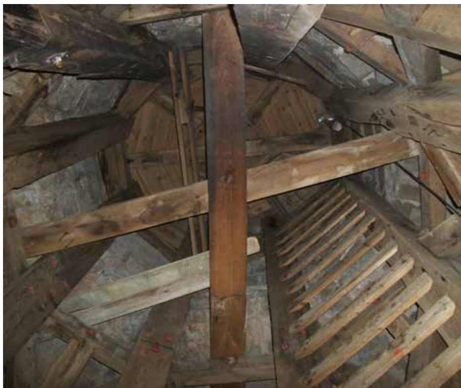
Charpente intérieure du dôme.
