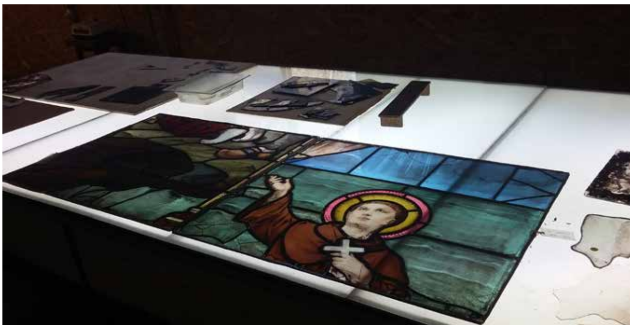
Vitrail de Saint-Goustan, restauration des panneaux en cours.
