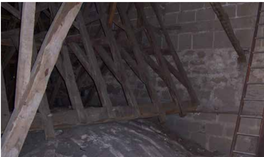
Charpente secondaire et mur nord soutenant la charpente principale.
