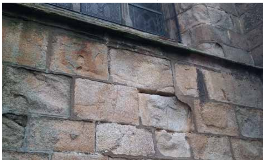
Façade ouest - parement dégradé et joints ciment.
