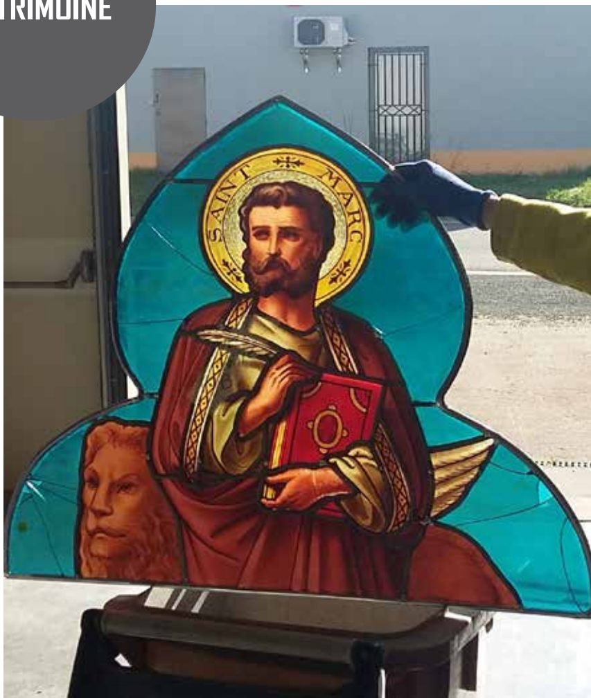
Vitrail des Évangélistes - Saint-Marc après nettoyage et sertissage
