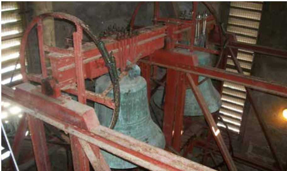
Beffroi métallique soutenant les 4 cloches.
