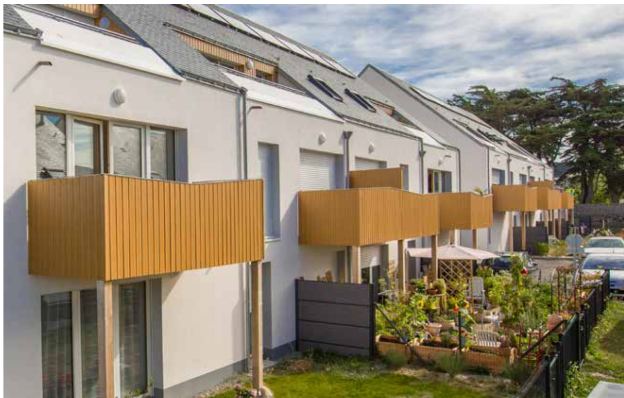
Le Courtil de Kervaudu, trente logements sociaux supplémentaires
