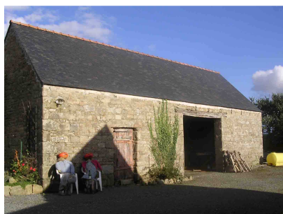
Grange à deux ouvertures - Kermocaër
