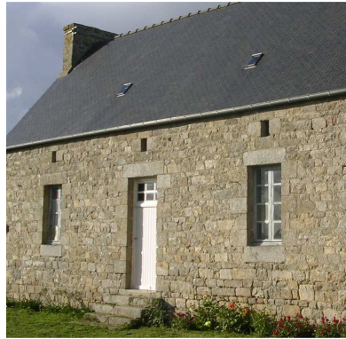
1- Village de Kermocaër Jours d'aération pour le grenier au dessus des ouvertures
