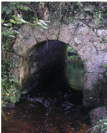
Pont avec arche en plein cintre
