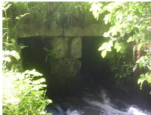
Pont à deux travées
