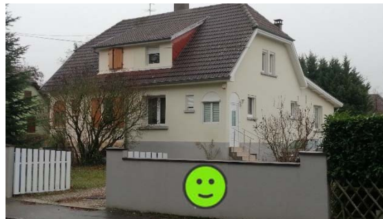
Mur maçonné enduit
