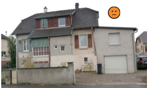
Toiture monopan en dessous de l'égout du toit, mais extension doublant presque l'emprise au sol et absence de décrochement.
