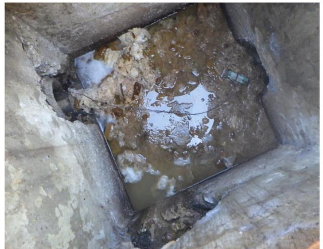
*Dépôts, Stagnation d'effluents – Regard n° 21034 – Réseau EU – Rue des 4 Vents*
