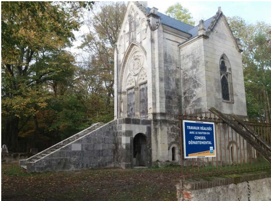
L'escalier de la chapelle de Rocheux a été réhabilité
