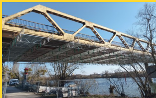
Travaux pont de Courcelles
