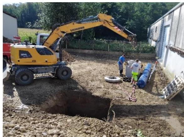
L'aménagement extérieur a été également réalisé, l'infiltration des eaux pluviales se fera par un puits perdu.
