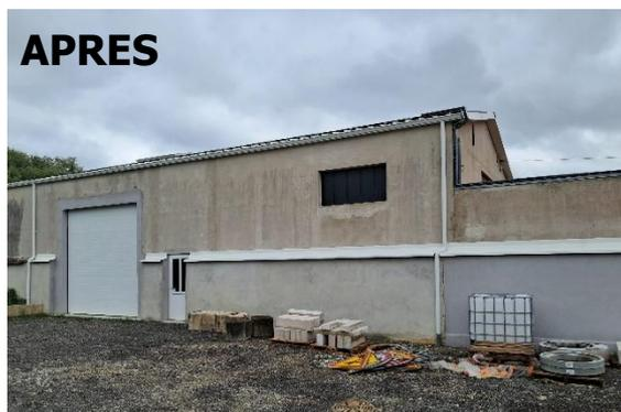
Installation d'une porte sectionnelle et d'une porte pvc et nettoyage de la façade.
