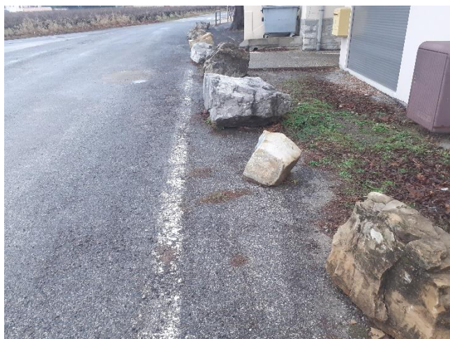
Blocs de pierres sur l'OAP
