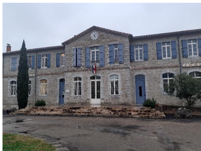
Toiture et interstices derrière les volets de la mairie favorables aux chiroptères
