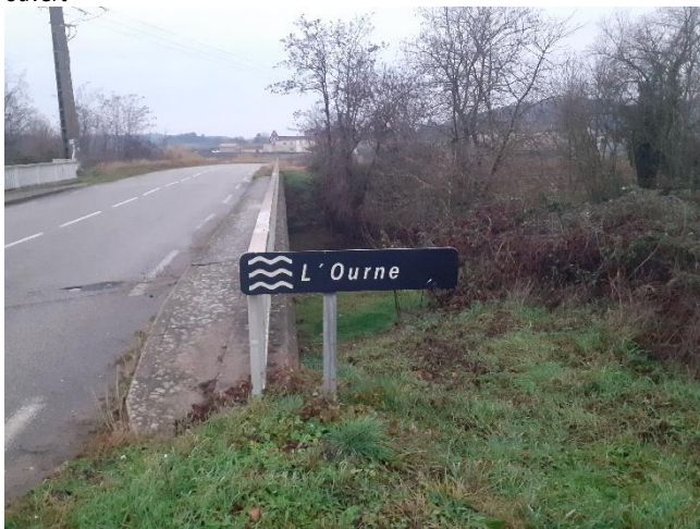
L'un des ponts enjambant l'Ourne.
