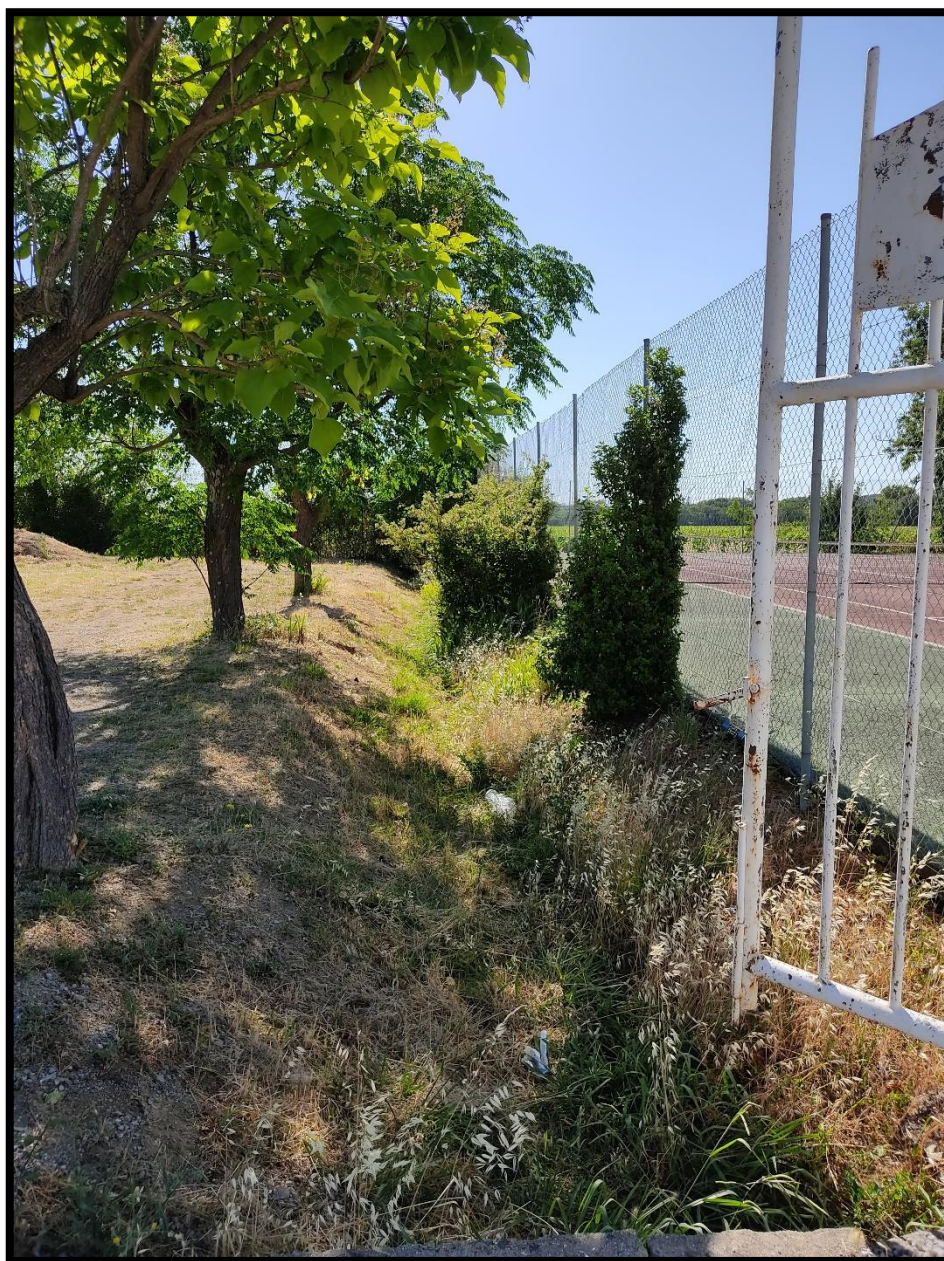
Figure 12 : Photo du fossé le long du stade au Sud au droit du cours de tennis
