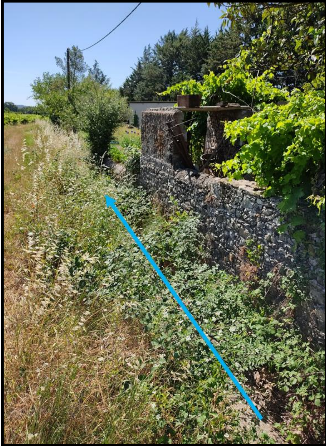
Figure 9 : Photo du cours d'eau après le passage sous la RD n°982 au Nord du stade
