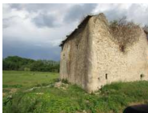
Source : Visite de terrain
