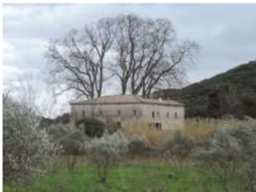
Source : Visite de terrain
