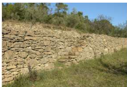
Les terrasses des constructions monumentales pour cultiver la terre.
