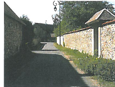
C 3 Beaux murs rue de l'Abreuvoir
