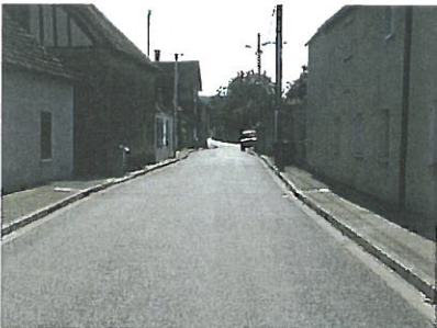
C 9 Rue de Boncourt, vue vers l'extérieur du village; on remarque la continuité bâtie tout le long de la rue
