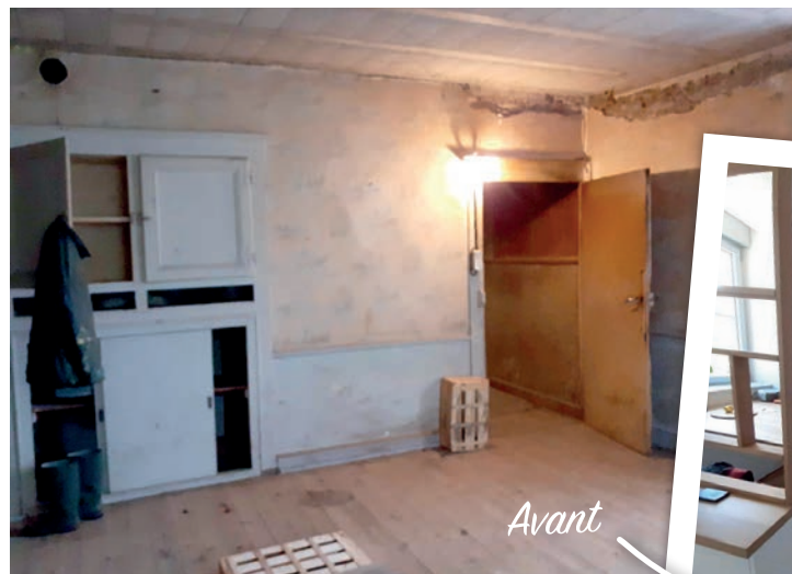
Rénovation d'immeuble à Malans
