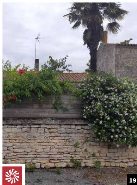
Ici une palissade de planches horizontales réussit à surélever joliment ce mur : la patine du bois brut se rapproche des tons de la pierre ; le végétal apporte de l'animation et rompt l'effet d'horizontalité. Ce dispositif fonctionne bien sur ce mur avec couverture de pierre. Cette composition sur un muret chapeauté de tuiles sera plus difficilement harmonieux.
