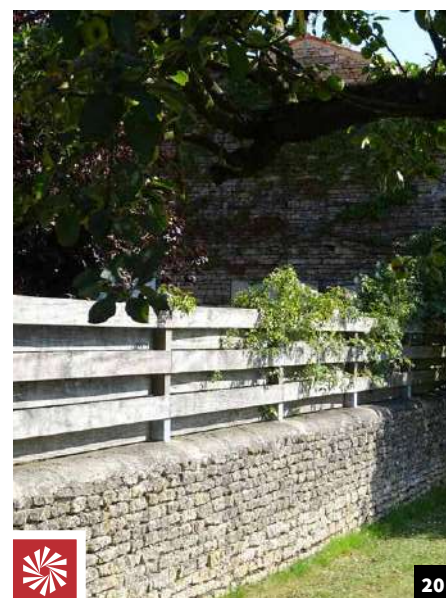
Dans cette composition horizontale, les planches alternées offrent relief, support pour le végétal et rendu esthétique intéressant des deux côtés. (Maillé)
