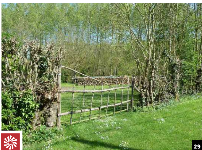
Ce portail est monté à partir de simples perches, complété d'un grillage souple et assure harmonieusement son rôle. (Le Vanneau)
