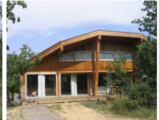
Maison à Peyregoux (Architecte : Max Faramond)
