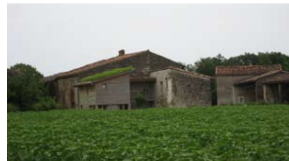
Exemple d'extension contemporaine en bois à Lautrec, avec toiture végétalisée
