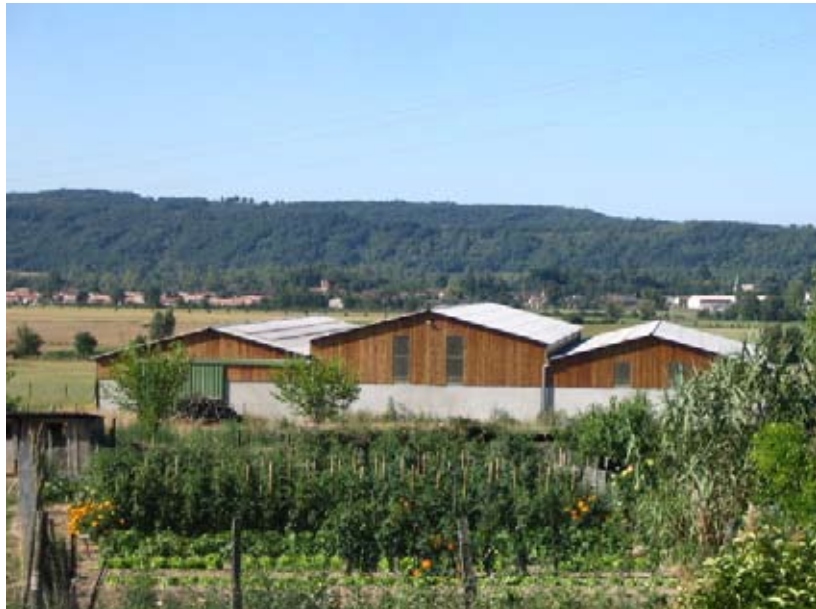
Un exemple de 3 hangars mitoyens en bardage bois à Serviès
