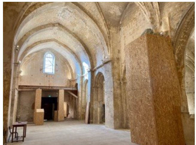
TRAVAUX INTERIEURS — ELEMENTS DE PROTECTION
