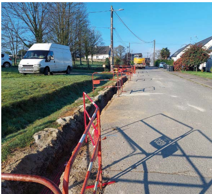
HTA en cours de travaux
