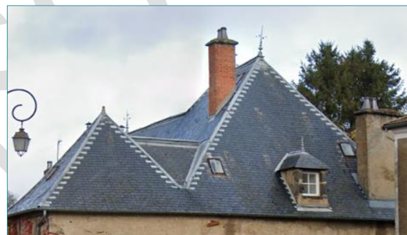
Pointes décoratives sur toit et couverture en ardoise - © Google streetview
