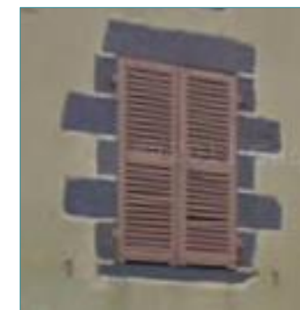
Lucarnes de fenêtre en pierres de Volvic - © Google Streetview
