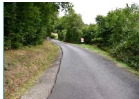
Accès au plan d'eau d'Anschald Route d'accès à double sens - Gabarit étroit et dégradation des accotements à l'approche du plan d'eau
