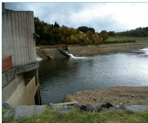
Arrivée d'eau au barrage source : https://aappmahautesioule.wixsite.com
