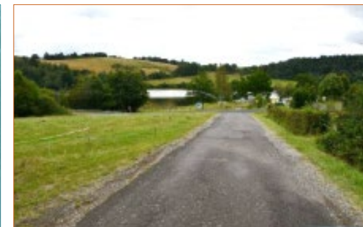
Accès au plan d'eau d'Anschald Route d'accès à double sens - Gabarit étroit et dégradation des accotements à l'approche du plan d'eau
