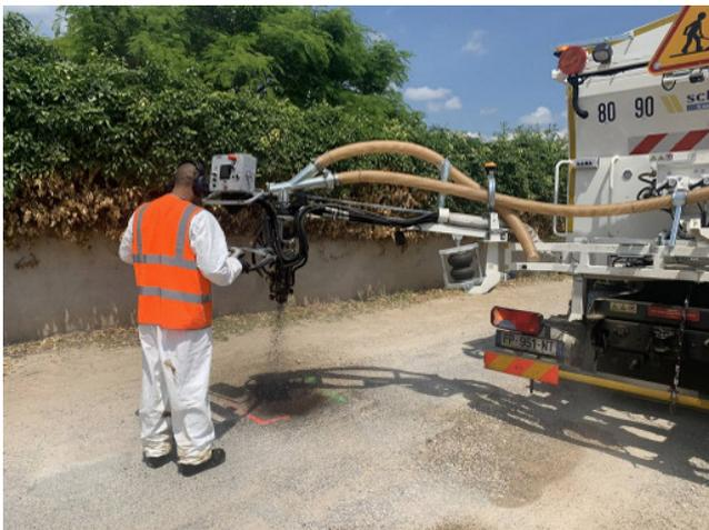
Les 6 et 7 mai, une opération de remise en état des voiries communales a été réalisée par la société EUROVIA. Le Blow-Patcher est une micro-centrale projetant de l'enrobé (gravier + émulsion de bitume) pour la réparation des dégradations des routes. C'est un enrobeur projeteur, qui permet de réparer les dégâts de chaussée localisés comme les nids de poule, le faïençage, l'arrachement d'enrobé, le défoncement des bords de chaussée...
