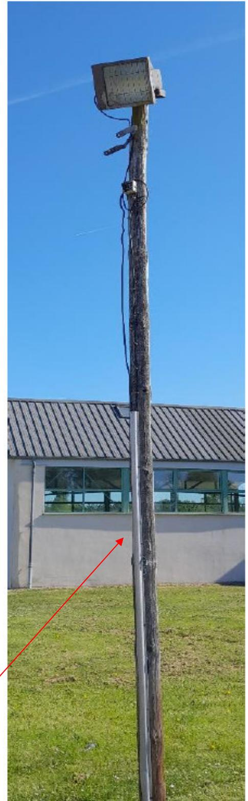
dépose complète du poteau bois avec mise en sécurité de l'installation électrique, pose d'un mât cylindro-conique de 10m RAL 8015 avec traverse double pour pose de 2 projecteurs LED type PHILIPS Coreline
