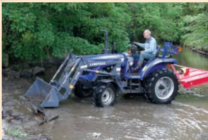
NETTOYAGE DU LAVOIR.
