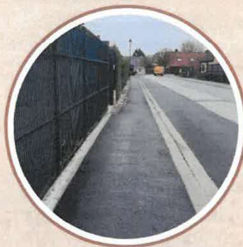
Création d'un trottoir rue de la Briqueterie
