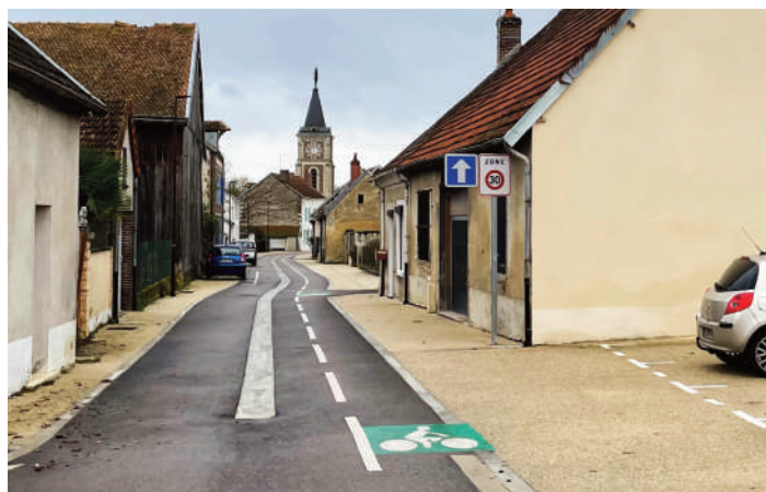
Rue Montpellier après travaux
