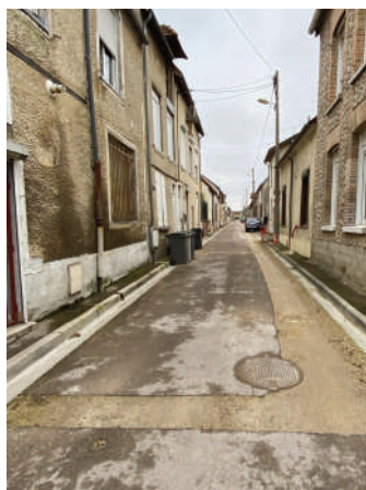
Rue Moyenne avant travaux
