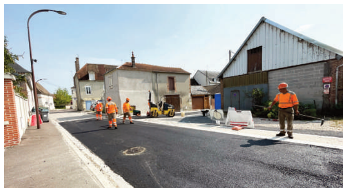
Rue Nationale/Rue de Bourdeaux : La pose des enrobés
