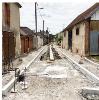
La rue Nationale : Coulage des bordures
