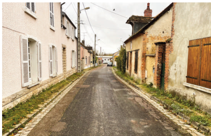
Rue Montpellier avant travaux
