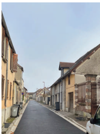
Rue Moyenne après travaux
