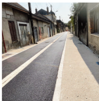
La rue Nationale : Travaux terminés
