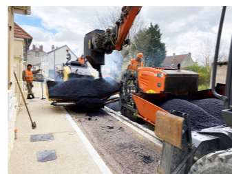
Pose des enrobés rue Chevalot
