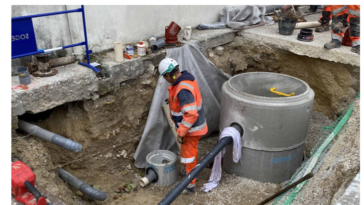
Pose d'un regard d'assainissement au pont de la Seine
