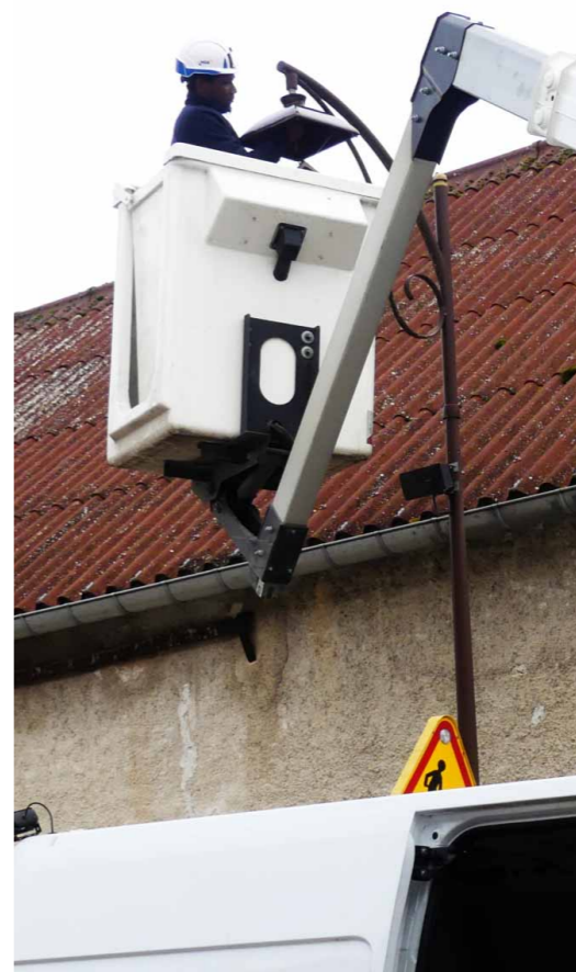
Pose des luminaires LED rue Delcœur
