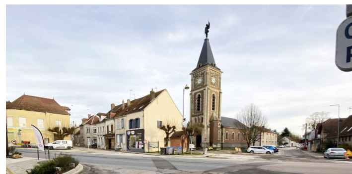
Emprise des travaux d'aménagement de la place Croala, phase 2
