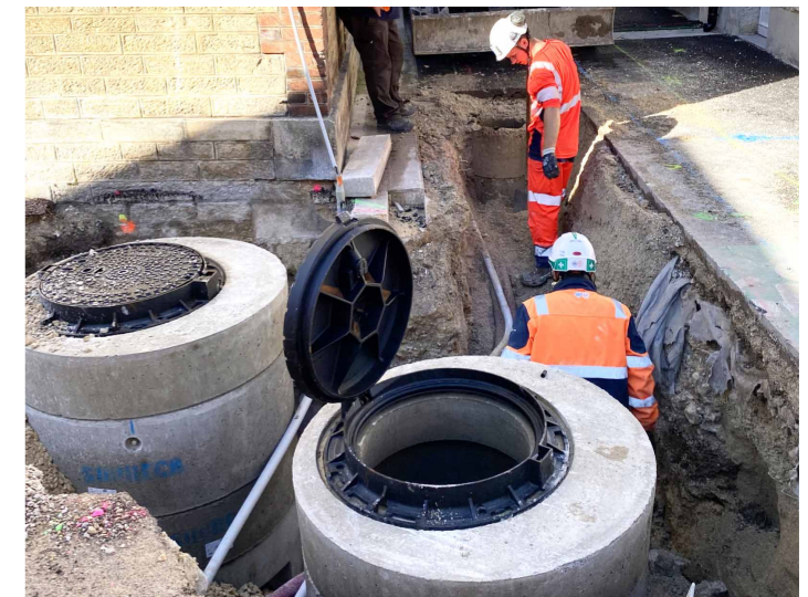
Pose d'un réseau d'assainissement au bas de la rue Chevalot
