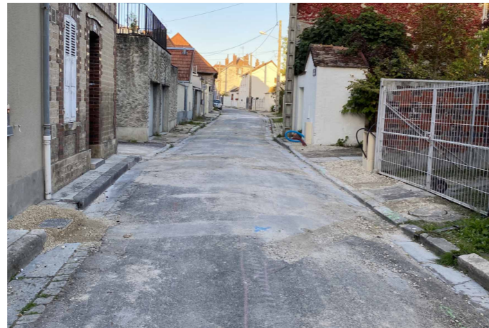
La rue Chevalot avant travaux
