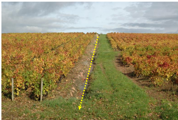
Figure 9 : fossés de drainage dans le secteur de la Pissevieille
