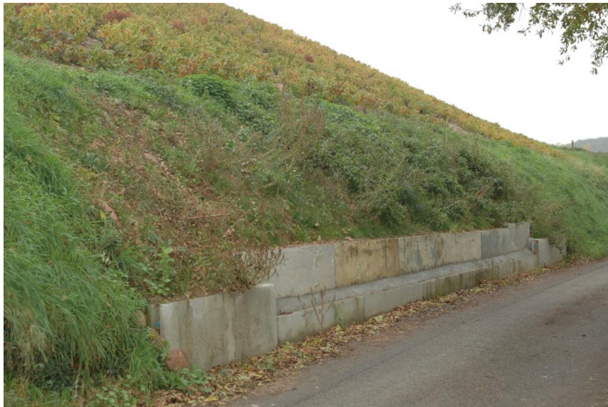
Figure 7 : vue de l'ouvrage de soutènement dans le talus de la route en pied de coteau
