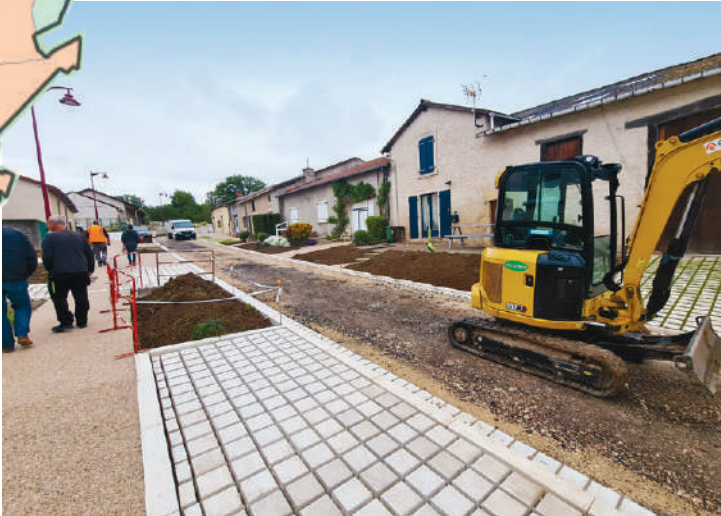
Réfection de la voirie de Nonsard-Lamarche
