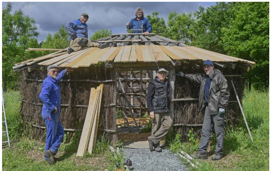
La loge de sabotier en cours de construction. Photo prise le lundi 12 mai 2025
