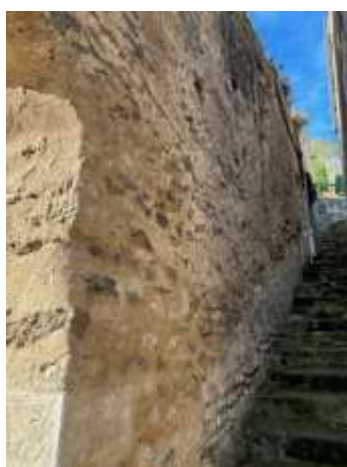
Avant les travaux- Vue de la Rue Basse
