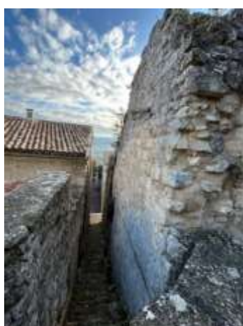
Avant les travaux – Vue de la Rue de l'Arnaudo
