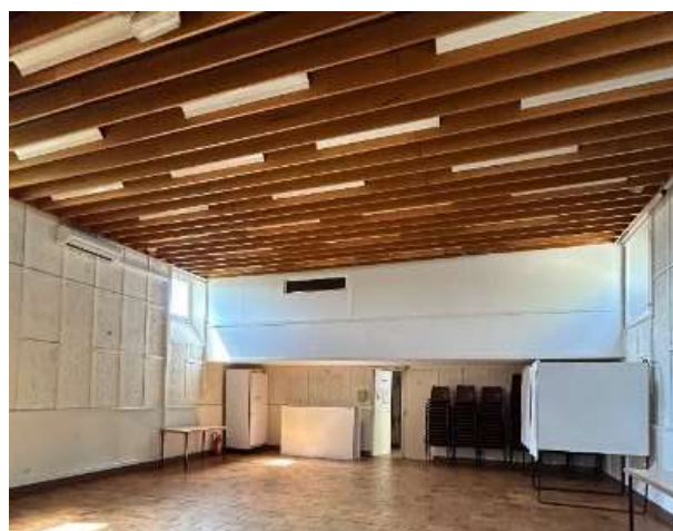
Avant la réalisation de tous les travaux
