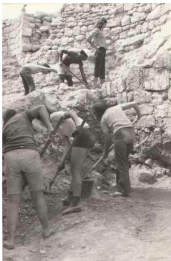
Chantier Rempart en petite équipe pendant les vacances de Pâques.
